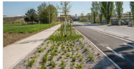
Auf Höhe Alte Poststraße/Kratkystraße sind bereits erste Maßnahmen der Grünraumoffensive ersichtlich. (Stadt Graz/Fischer (2))
